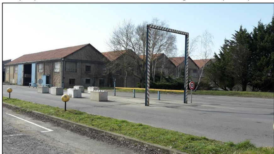
Bâtiment n°2 ligne de tri par flottation
