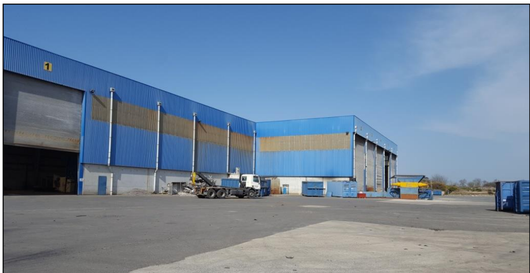
Bâtiment n°3 côté Est
