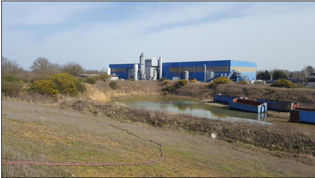
Bâtiment n°3 côté Ouest
